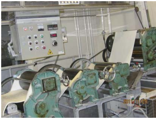
写真5 圧延工程、めん帯を薄く延ばす。
