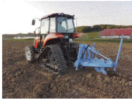
写真4 カットドレーン施工
