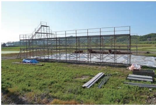
写真3 建設中の乾燥施設
